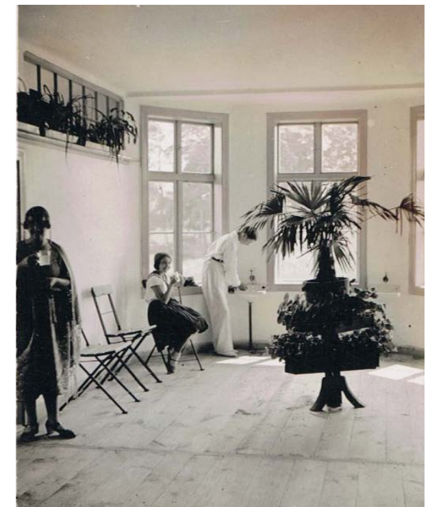
Ryc. 8. Wnętrze pjalni w Horyńcu. Lata 30. XX wieku
